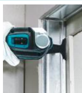
Remoção dos caixilhos das janelas
