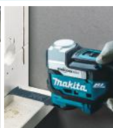
Trabalhos de abertura de portas
