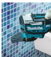
Colocação de juntas em revestimentos cerâmicos
